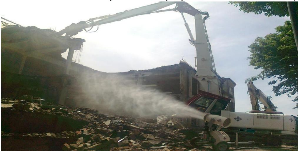
FOTO:Sistema di abbattimento polveri con cannone nebulizzatore (foto esplicativa)
