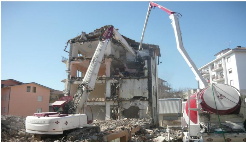
FOTO:Sistema di abbattimento polveri con autopompa con braccio radiocomandato (foto esplicativa)
